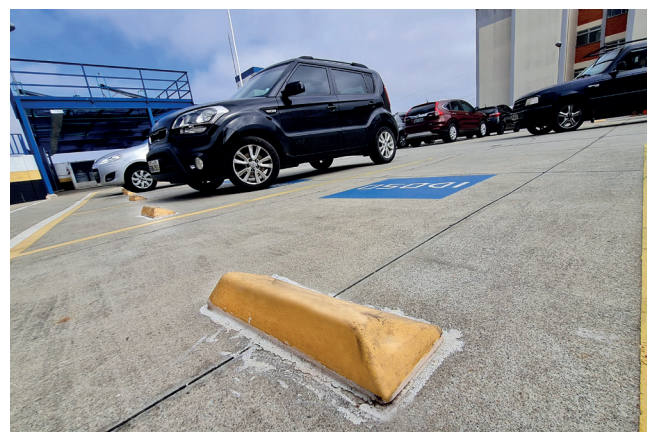
Segurança: Instalação de tachões no estacionamento
