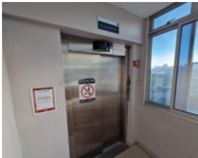
Modernização do elevador - Em andamento.
