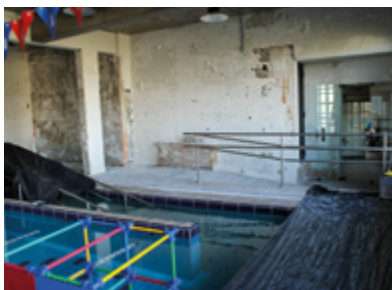
Reforma da piscina de hidroginástica - Concluída.
