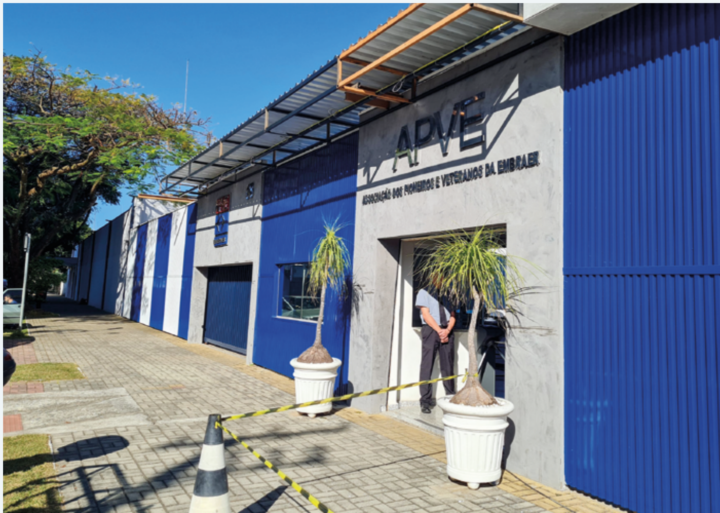
Fachada da APVE é uma das várias frentes de obras que vem sendo executadas na Associação.
