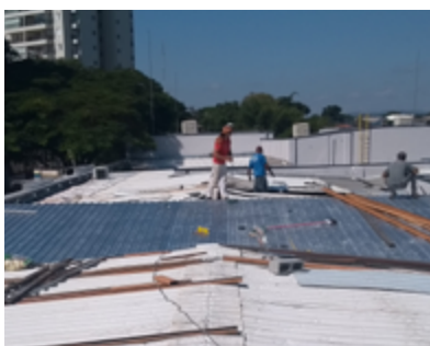
Obra do novo telhado - Concluída.
