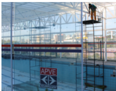
Reforma das piscinas - Em andamento.
