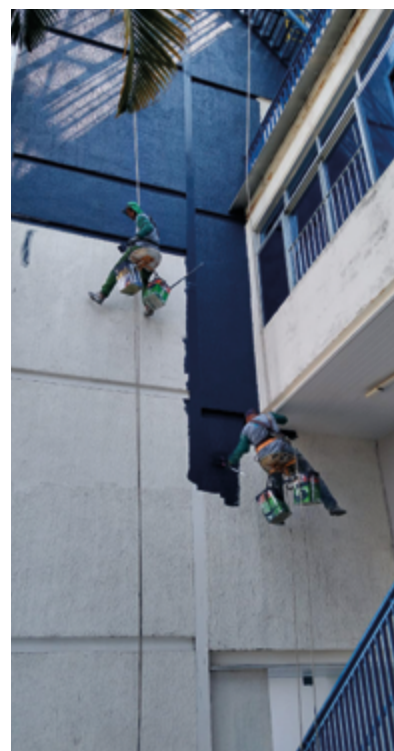
Pintura externa da sede - Concluída.
